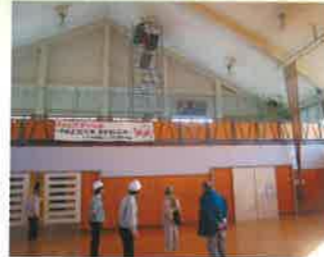
天井耐震診断状況
